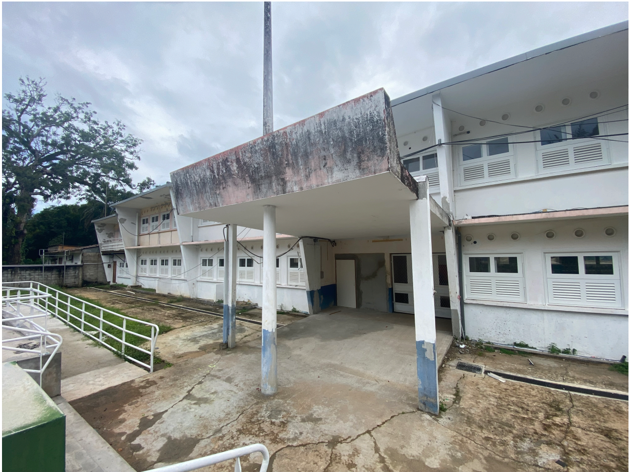
Détail de l'auvent d'entrée, novembre 2025
