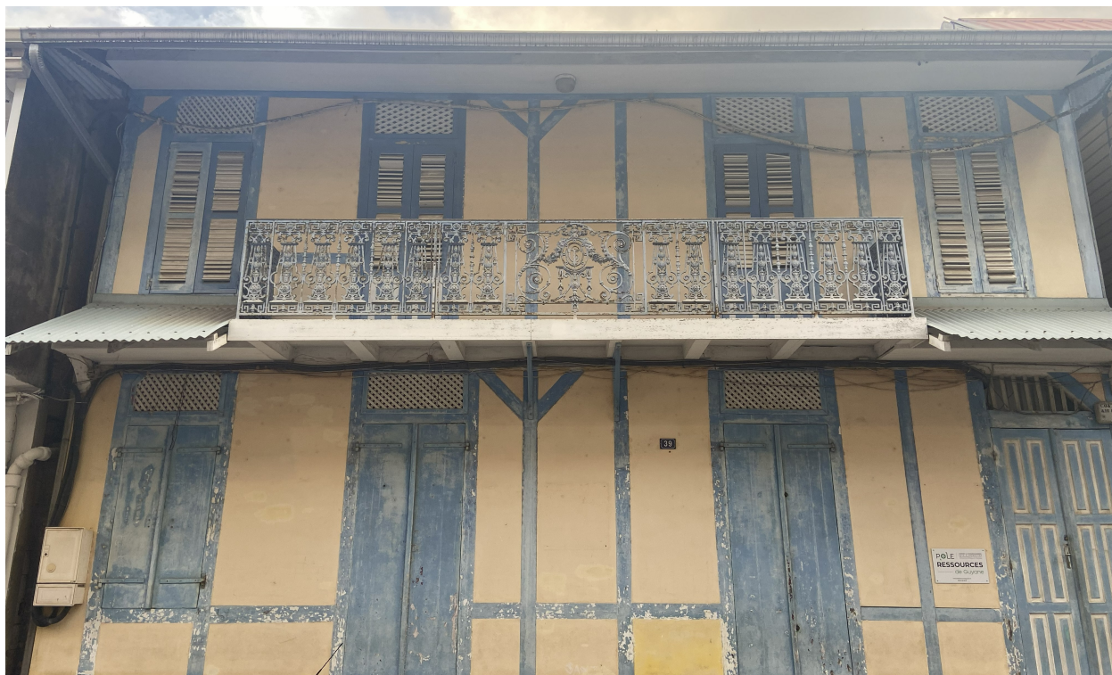
Façade sud, vue générale, état en 2026
