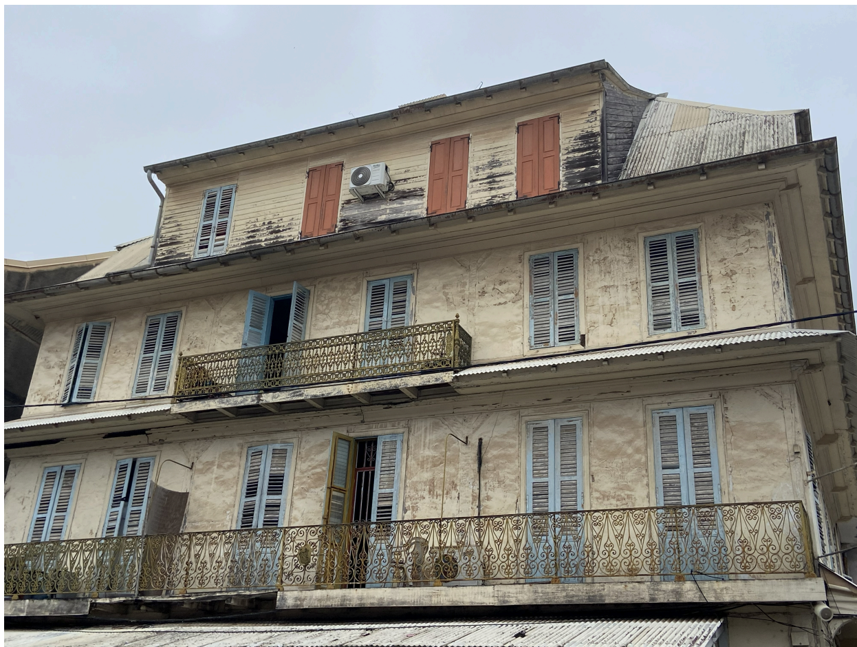
Détail de la façade ouest, état en juin 2026
