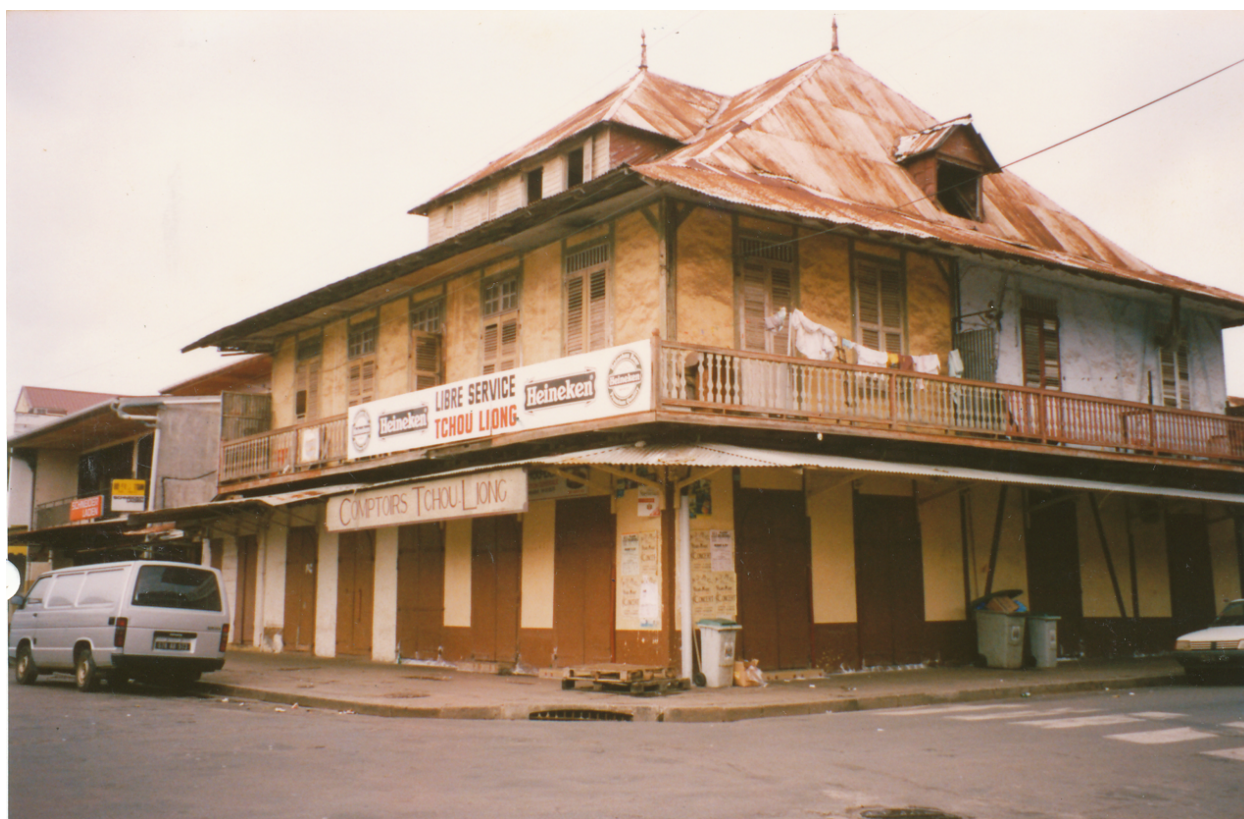
Vue générale en 1991, depuis le nord-ouest
