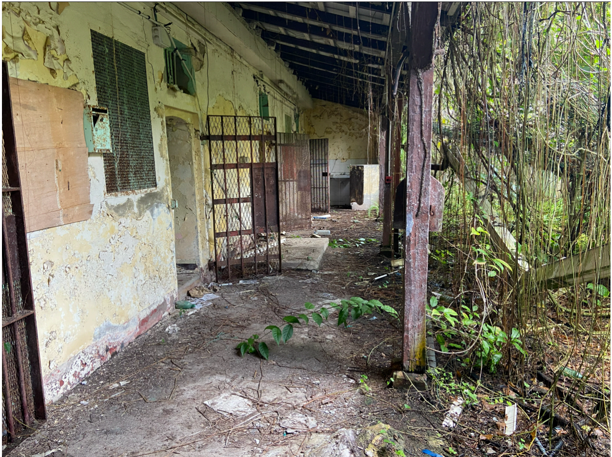
Angle sud-est de l'enceinte, quartier des femmes, état en mai 2026.
