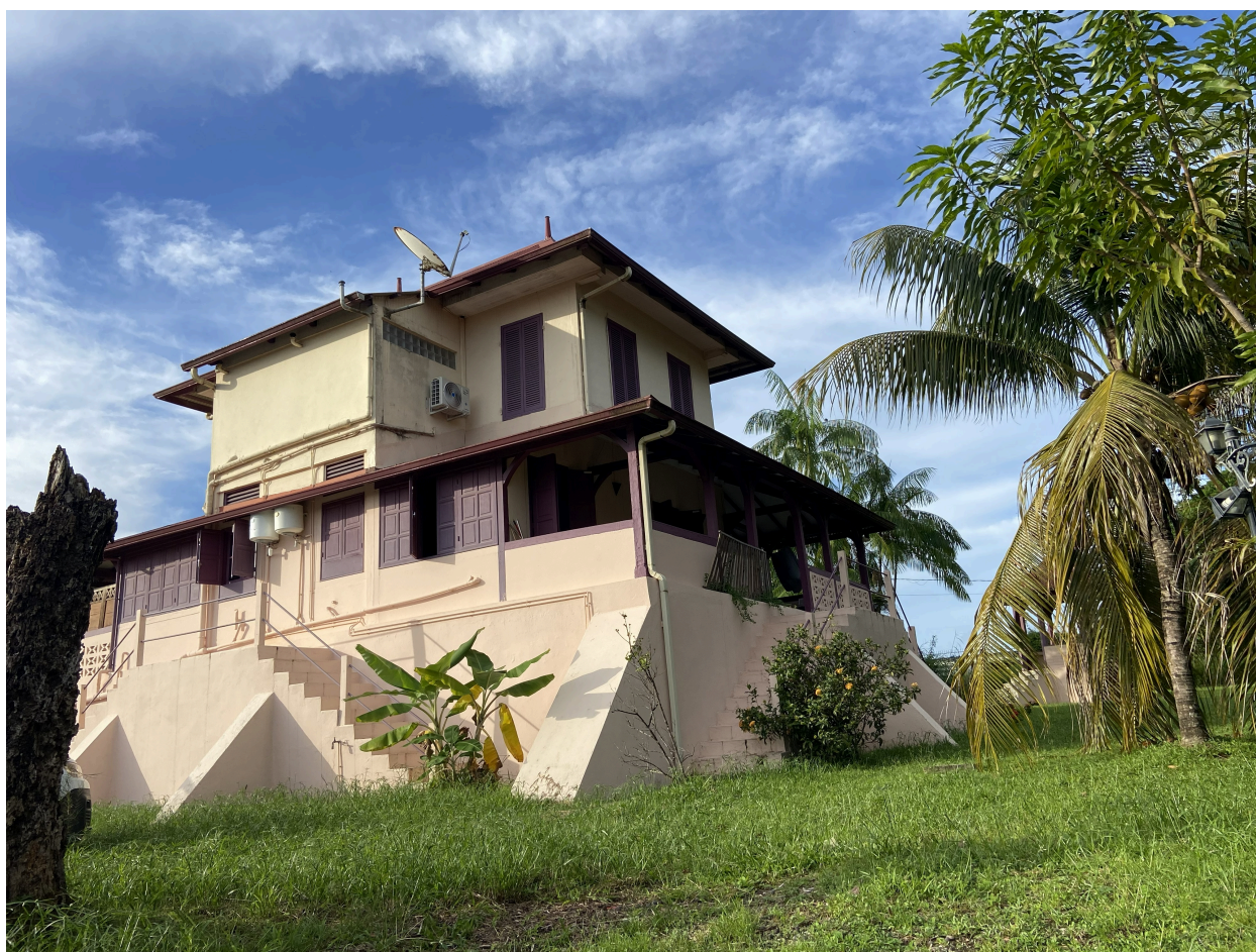
La maison depuis l'angle sud-est de la parcelle, état en mai 2026
