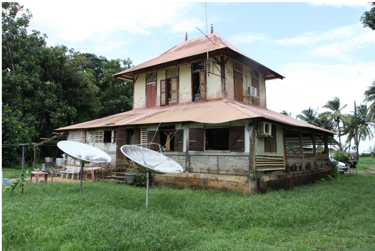
Vue depuis le sud, état en 2016
