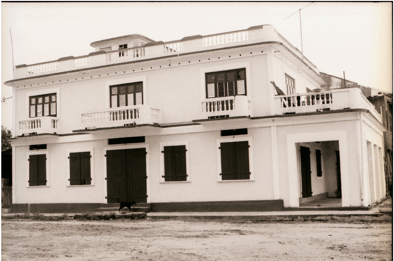
Vue générale de la façade sud sur la place Yves Patient
