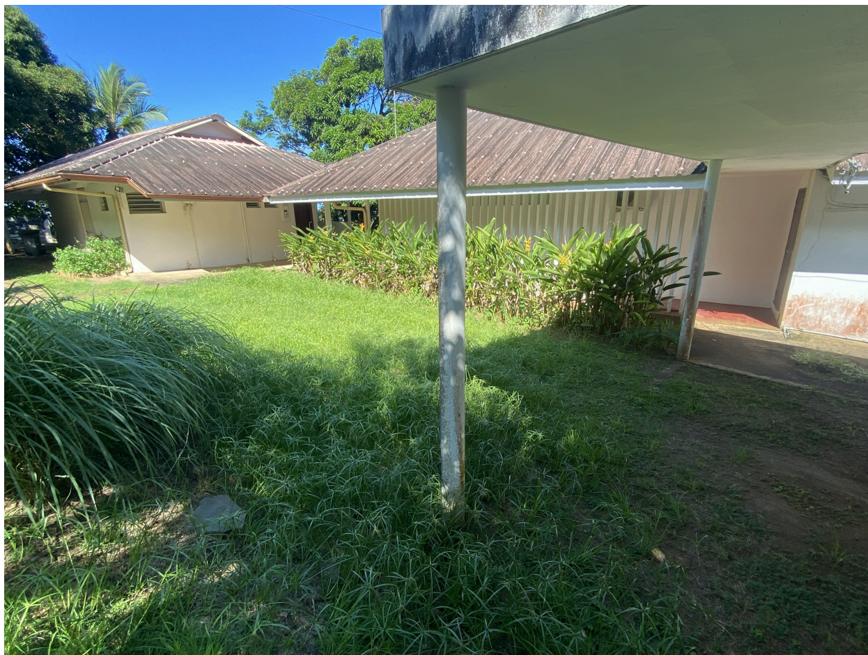
Vue générale de l'ensemble depuis le nord, juillet 2026
