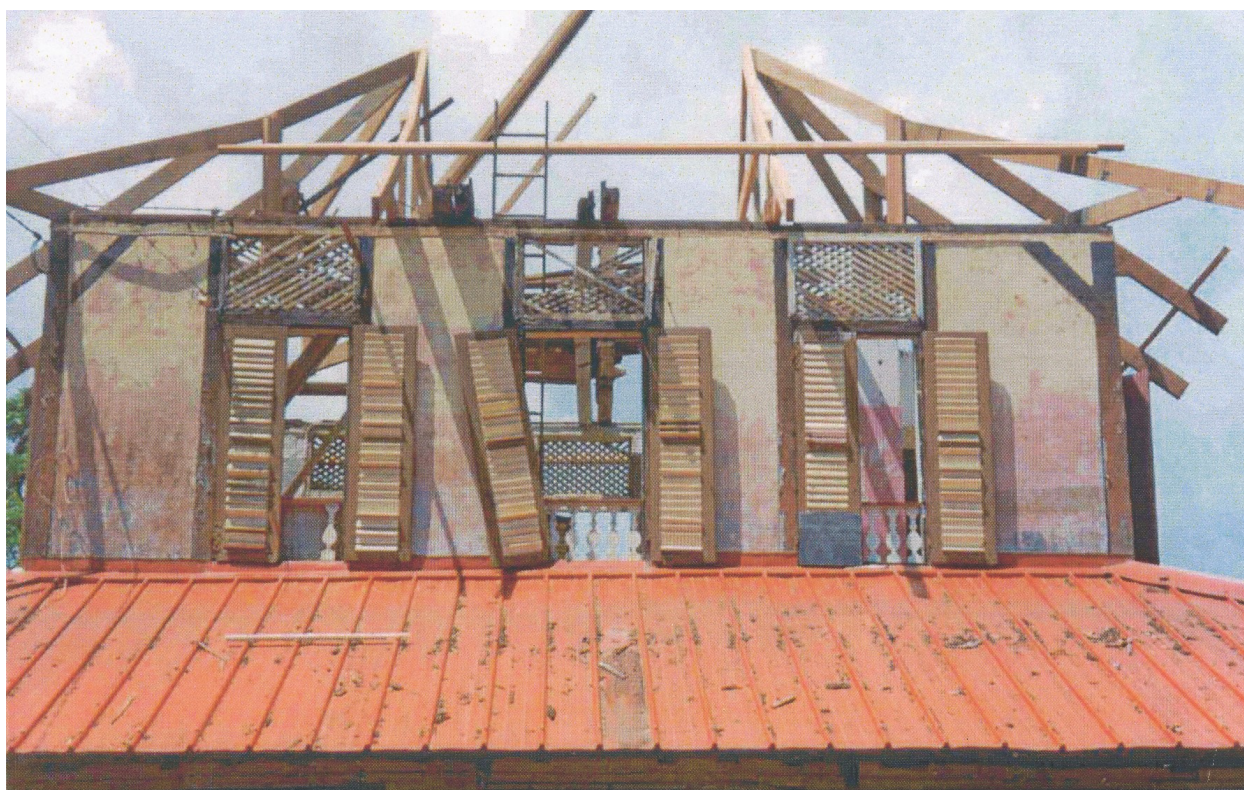
Réfection du toit en 1998, détail
