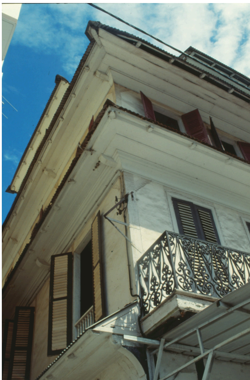
Détail de l'angle nord-ouest avant restauration, 1995
