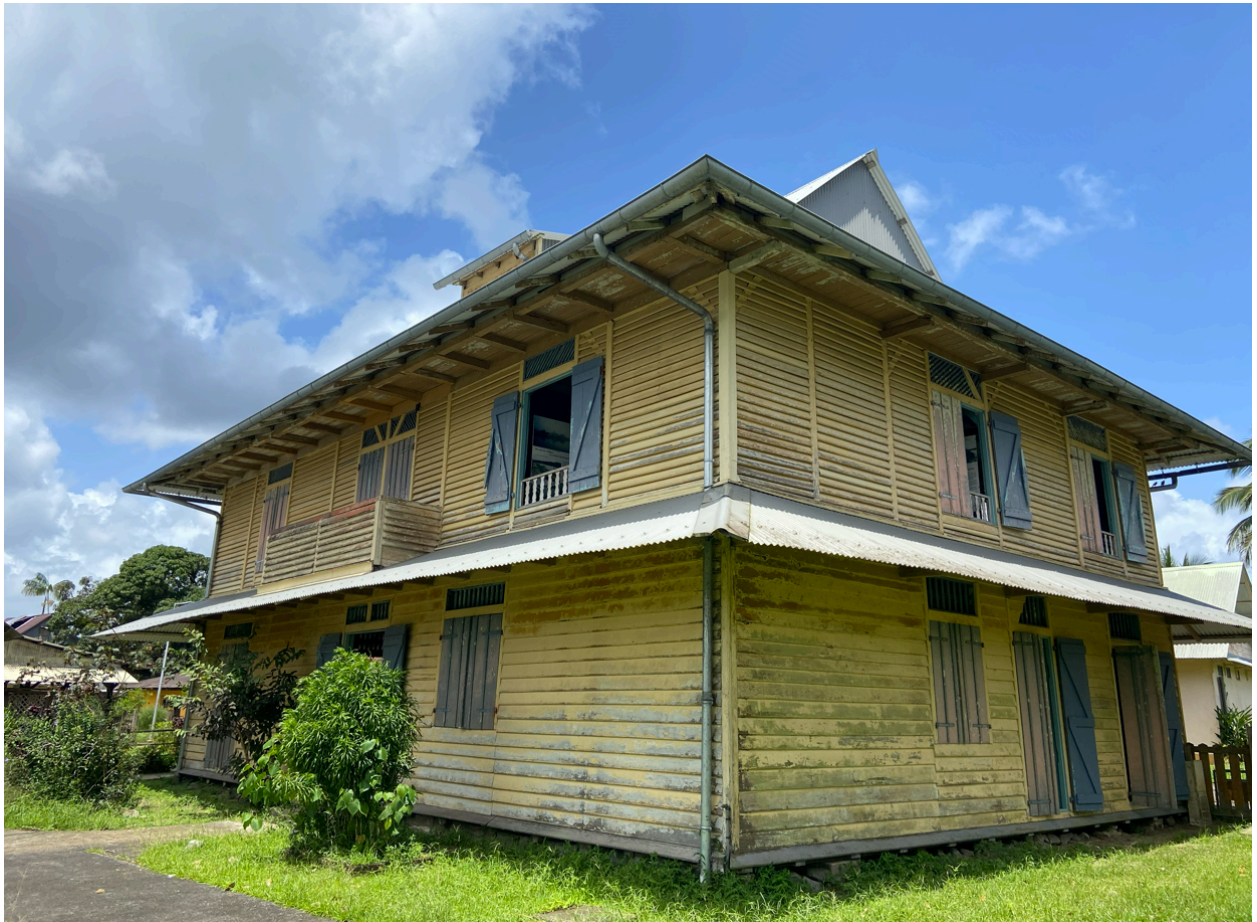
Vue générale depuis l'angle nord-ouest
