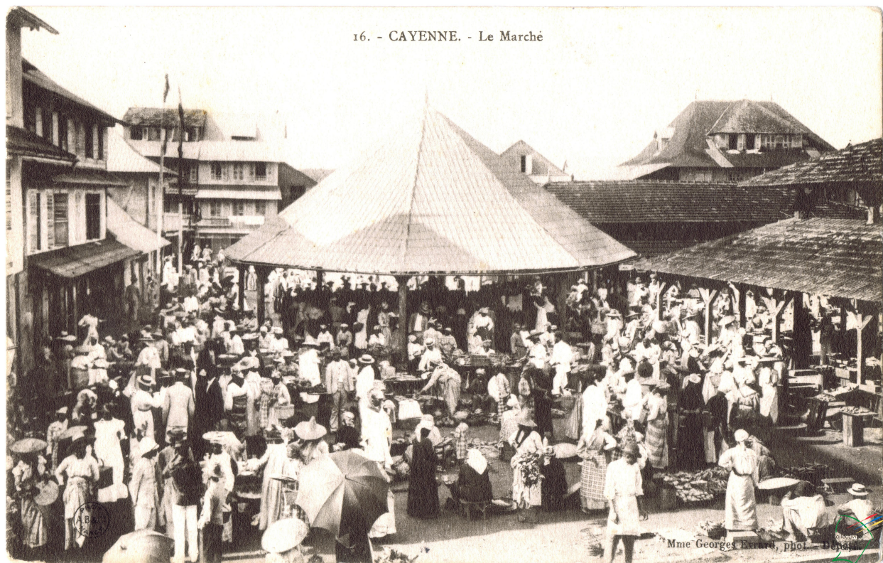
Le marché de Cayenne vers 1900. La maison domine à droite
