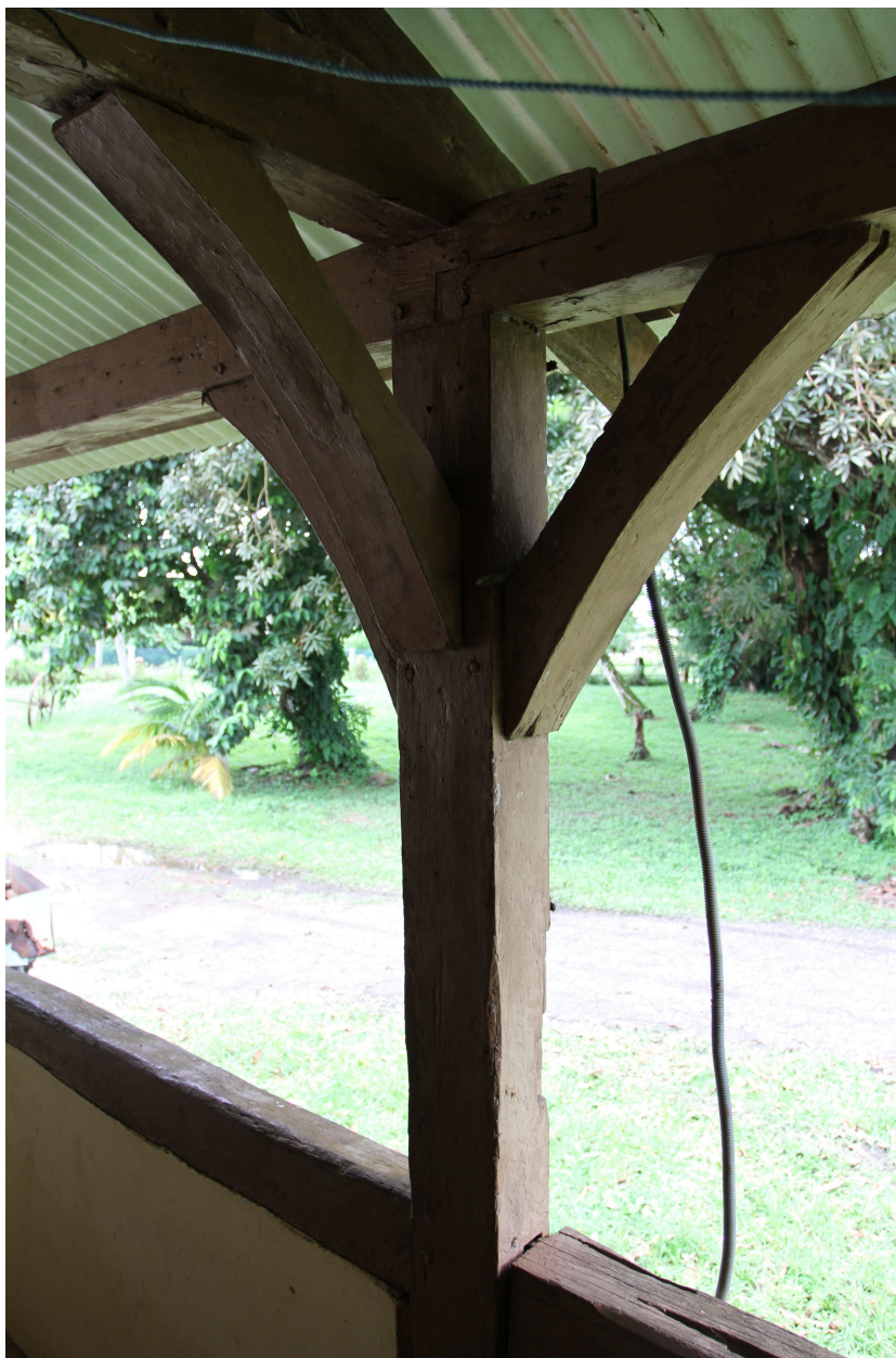
Détail d'un ensemble poteau-aisselier dans la galerie
