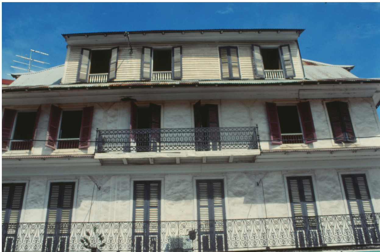
Détail de la façade ouest avant restauration, 1995
