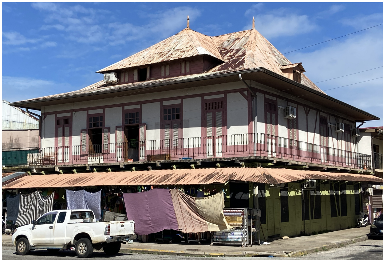
Vue générale depuis le nord-ouest, juillet 2026
