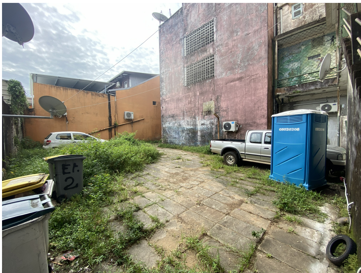
La cour, état en juin 2026
