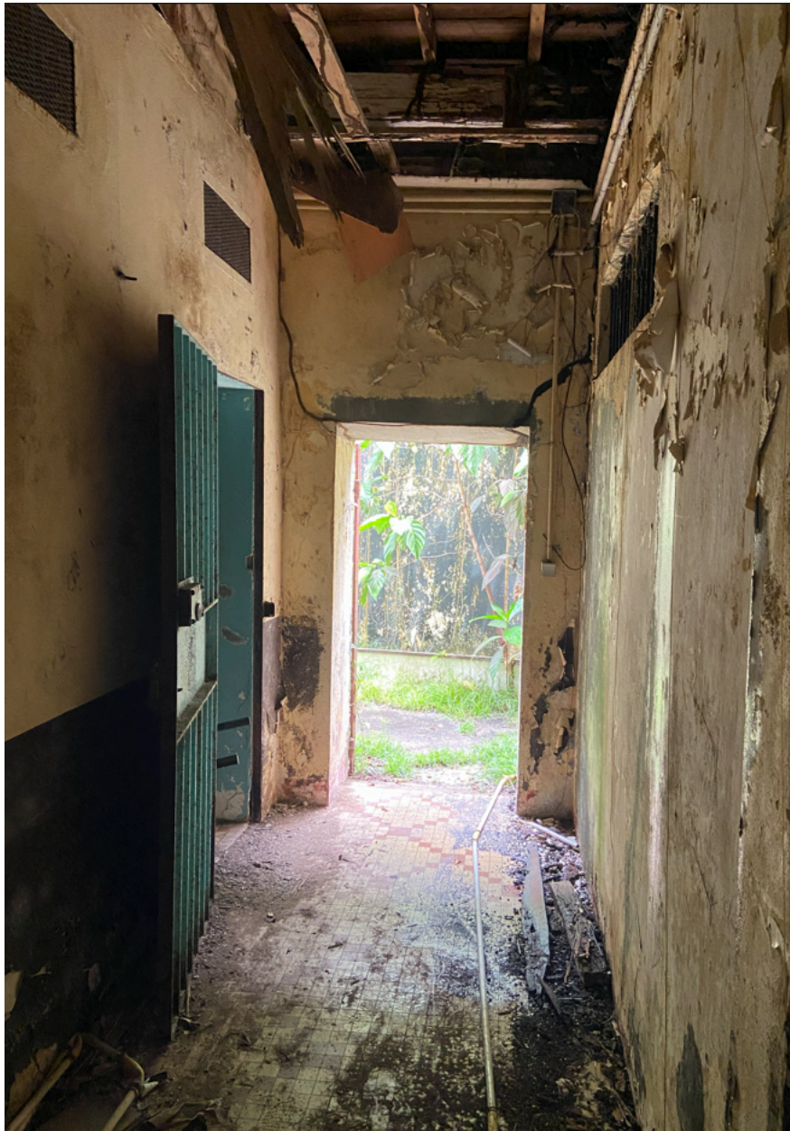
Vue de la distribution intérieure du pavillon central, état en mai 2026
