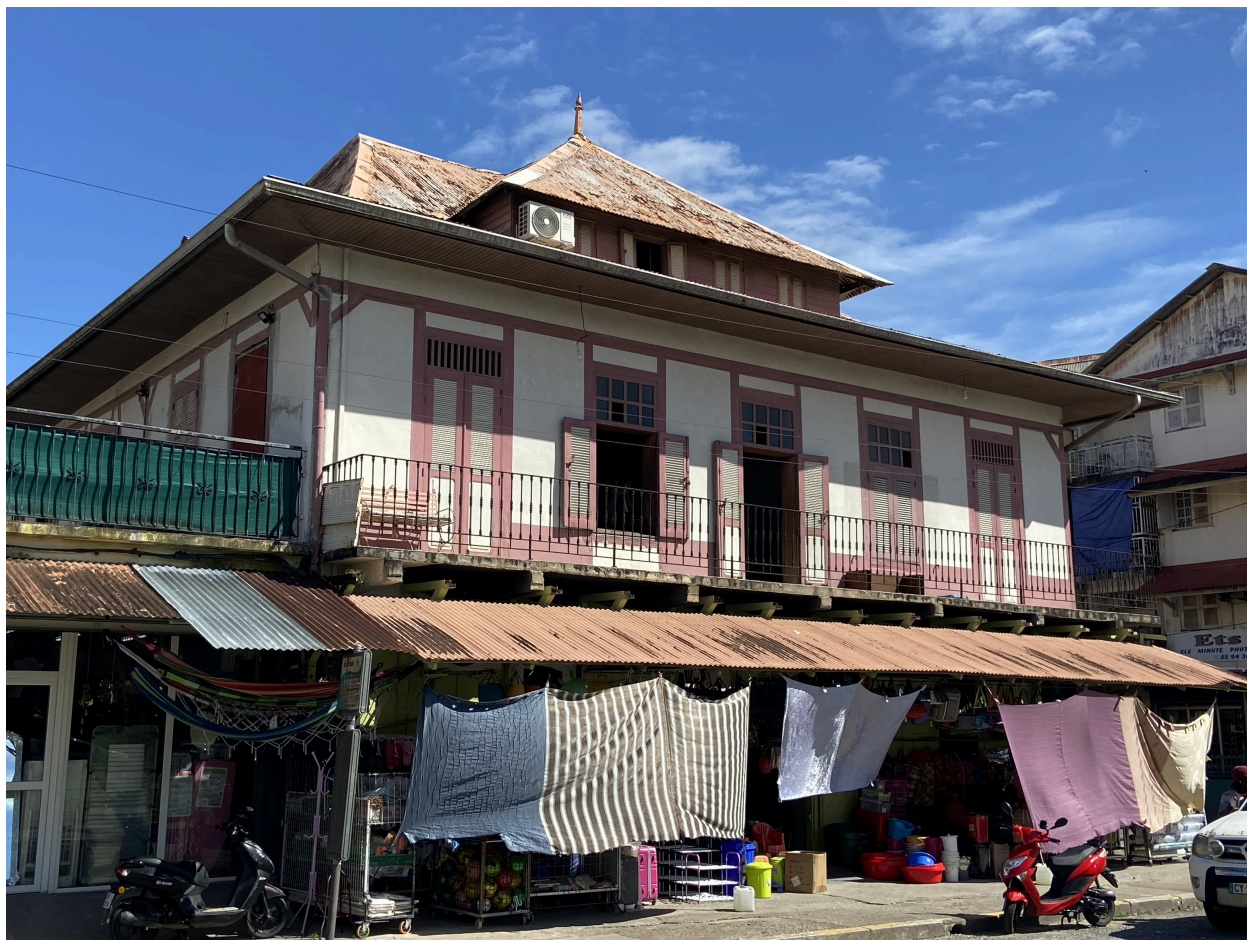
Vue générale depuis le nord-est, juillet 2026
