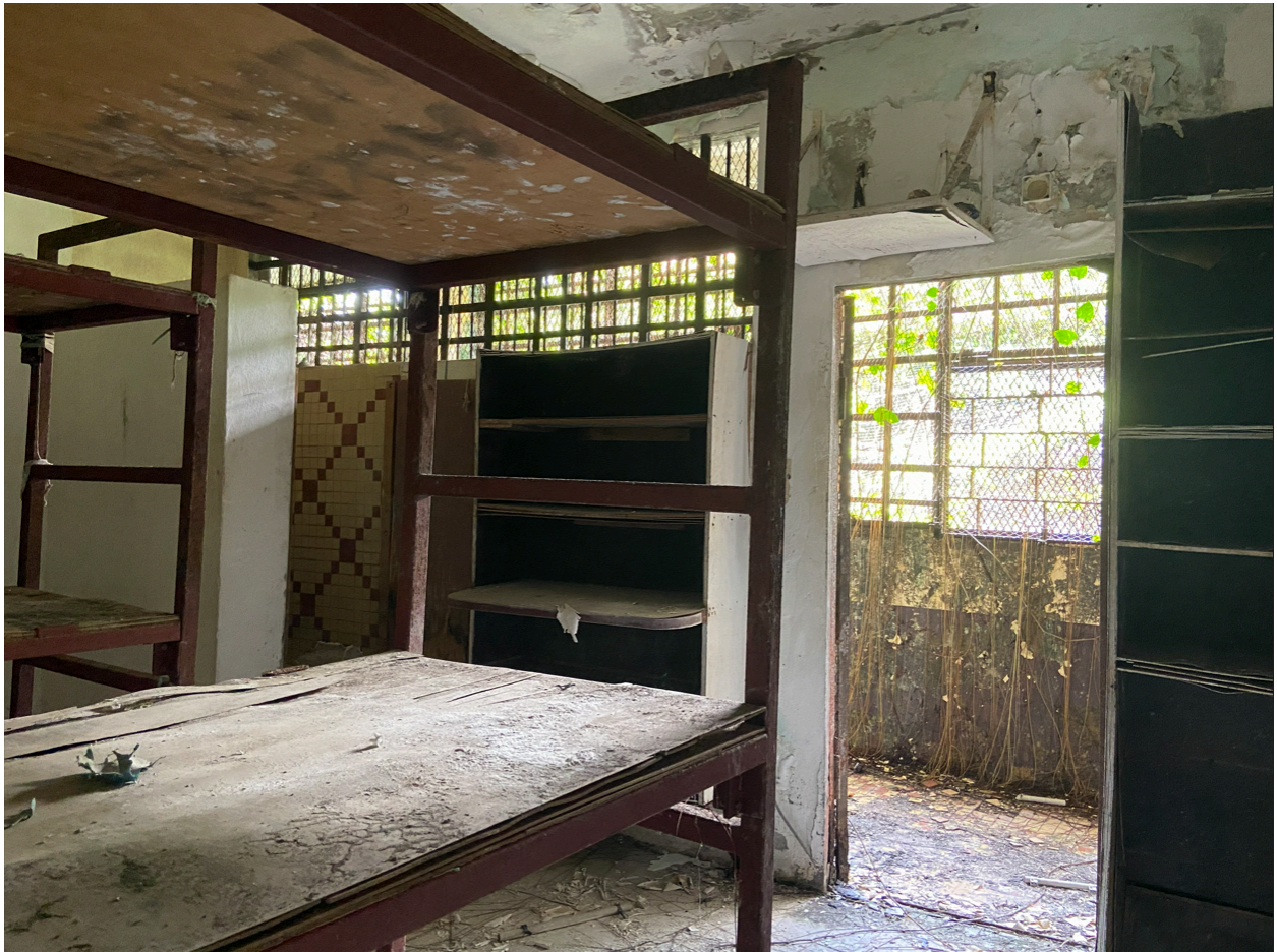
Quartier des mineurs, intérieur d'un dortoir, état en mai 2026.
