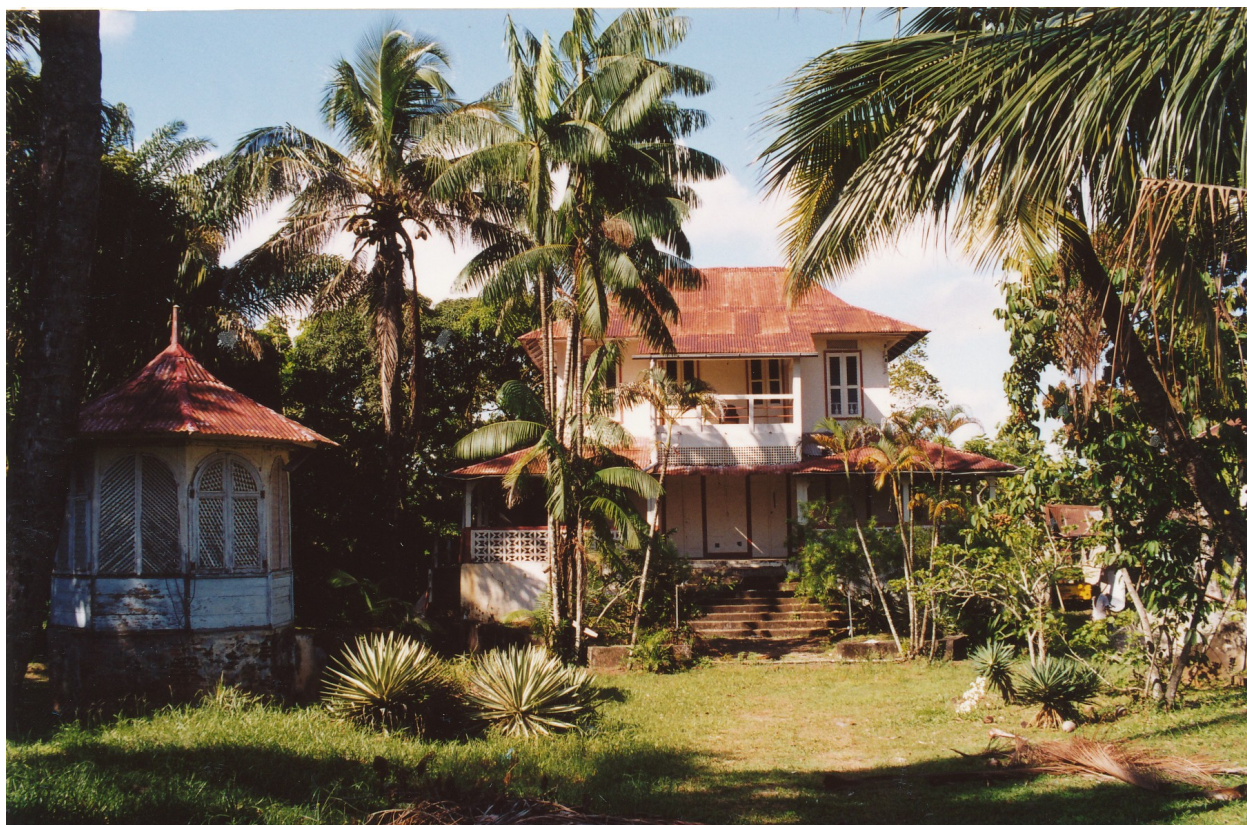
La façade nord de la maison de maître, état en 2002.
