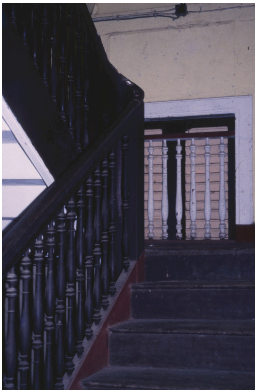
Vue intérieure avant restauration, détail des balustres,1995
