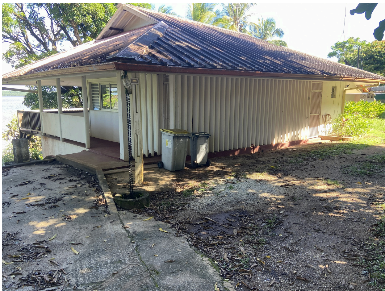
Vue du bâtiment A, séjour-cuisine, depuis le nord-ouest, juillet 2026
