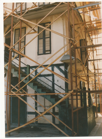
GUYANE CAYENNE Maison Vitalo Echafaudage pendant travaux
